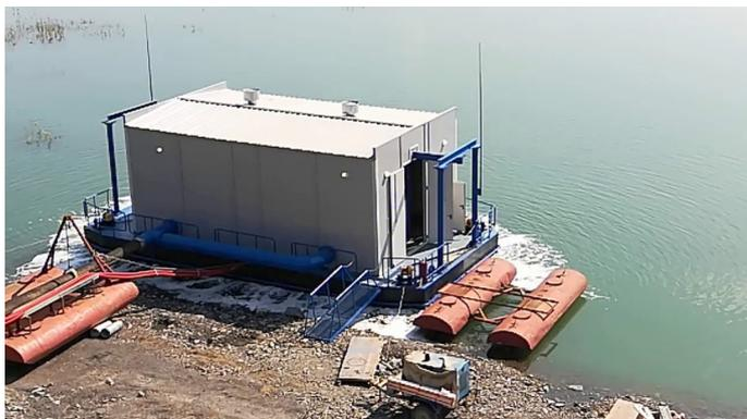
Передвижные насосные станции применяются в случае, когда технологически необходимо часто переносить места водозабора, а также при относительно небольших объемах подачи воды и при коротком периоде выполнения данных работ.
