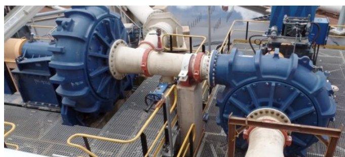
Рис. 8. Последовательное включение грунтовых насосов
