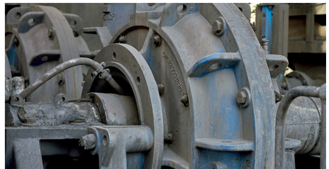
Рис. 10. Параллельная установка грунтовых насосов
