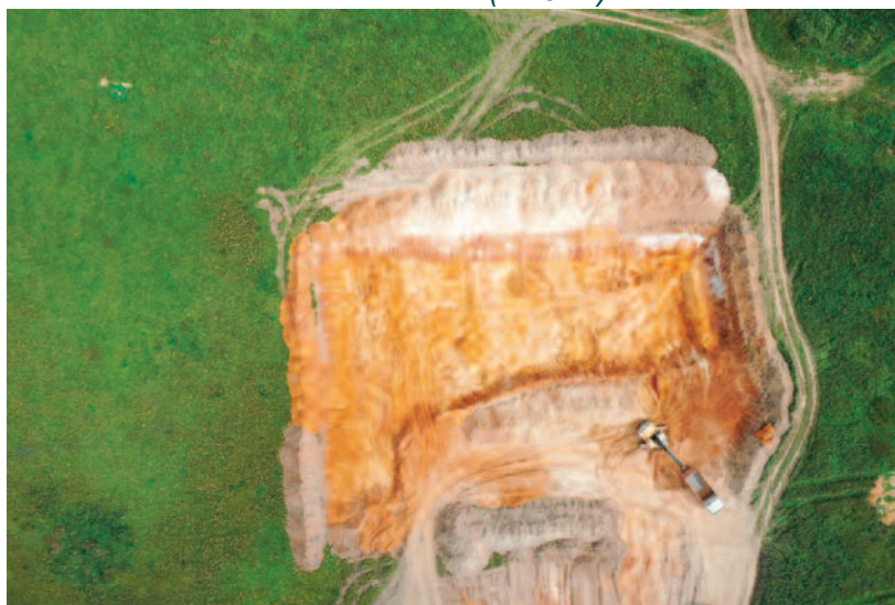
Рис.1- Ортофотоплан участка работ за первый месяц наблюдений в период вскрытия карьера и удаления вскрышных пород
